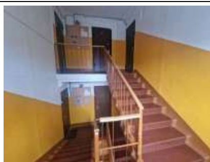
5.stāva kāpņu telpa
